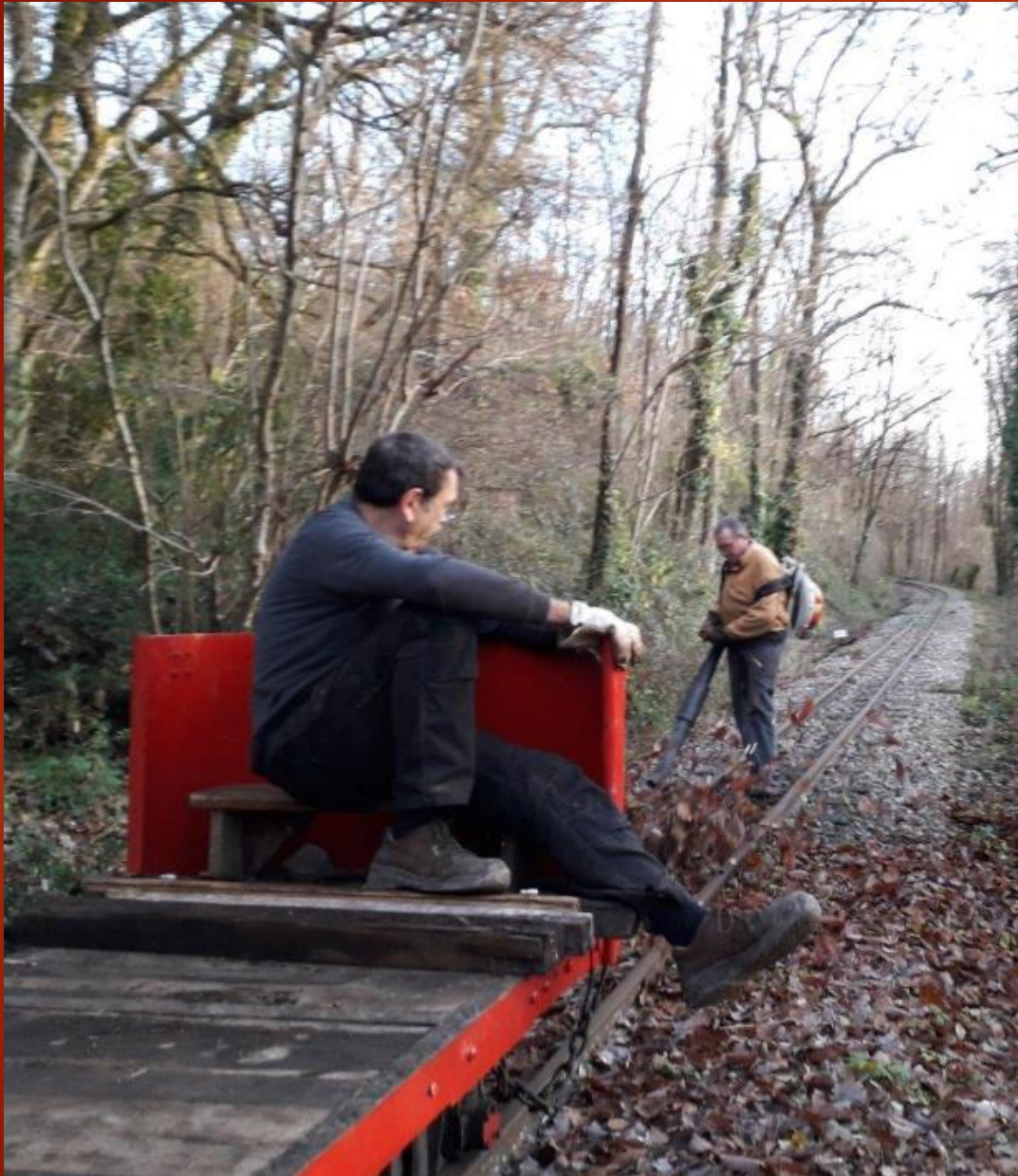
Soufflage de la voie, encore 300 m à faire
