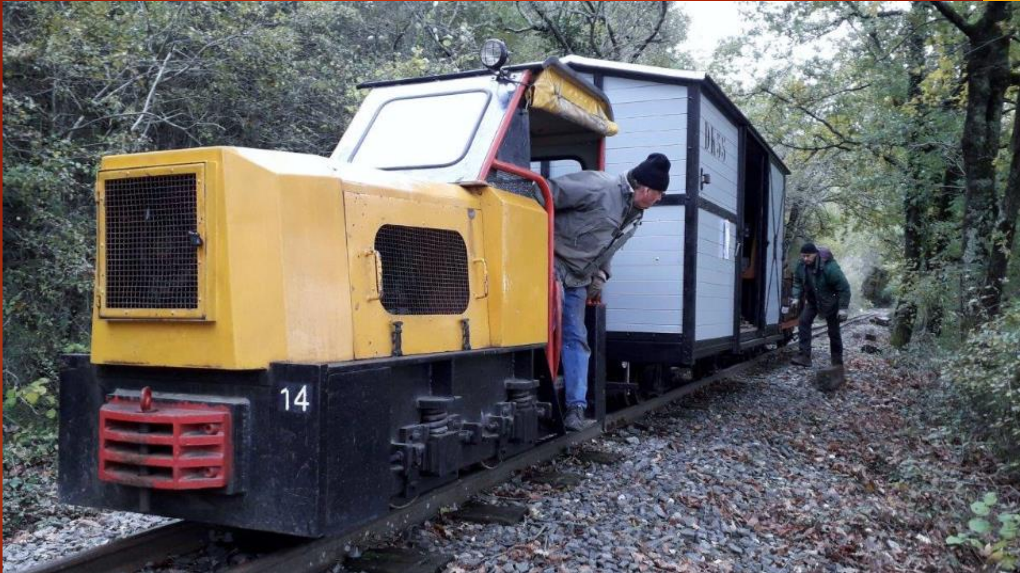
Le train de travaux en bas du bois, déchargement des traverses neuves
